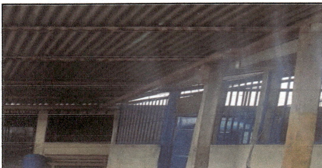
Foto 5: SE OBSERVA LA INSTALACION DE PUERTA Y BALCON DE AULA.
