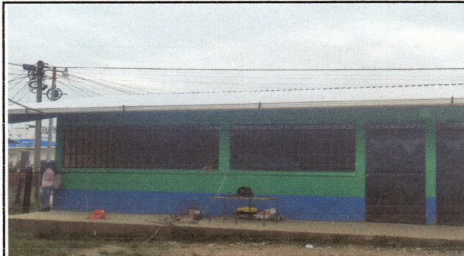
Foto 4: SE OBSERVA LA INSTALACION DE CANALES DE BAJADA DE AGUA PLUVIAL.
